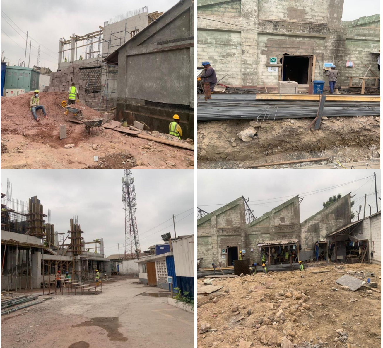
Photo n° 1 : Etat actuel du site en construction
